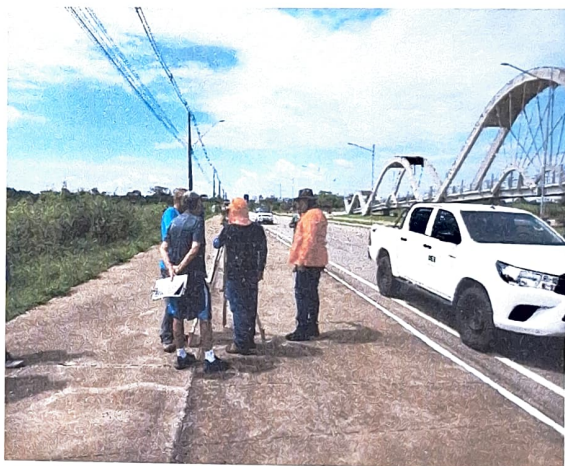
Foto 10 - Topógrafo locando os furos em campo
