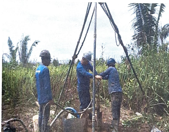
Foto 3 - Sondagem por lavagem (circulação de água)
